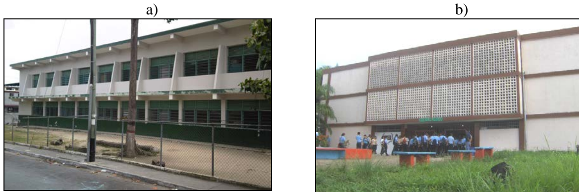
Figura 1.4. Escuelas antiguas; a) Antiguo II “Escuela Alberto Ravell, San Felipe; b) Cajetón, Escuela Francisco de Miranda, Edo. Monagas.
